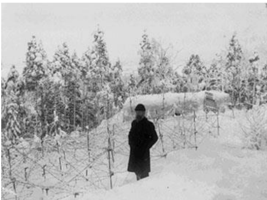
Bildet av piggrådhindret med en av kaponierbygningene i bakgrunnen. (kilde: FM, bildesamlingen, fotografi tatt av Wilse)
